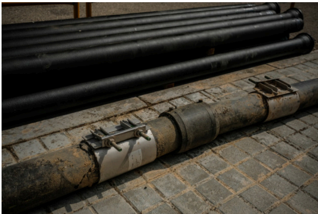
La renovación de tuberías servirá para evitar fugas en el sistema. Foto de archivo de EP
